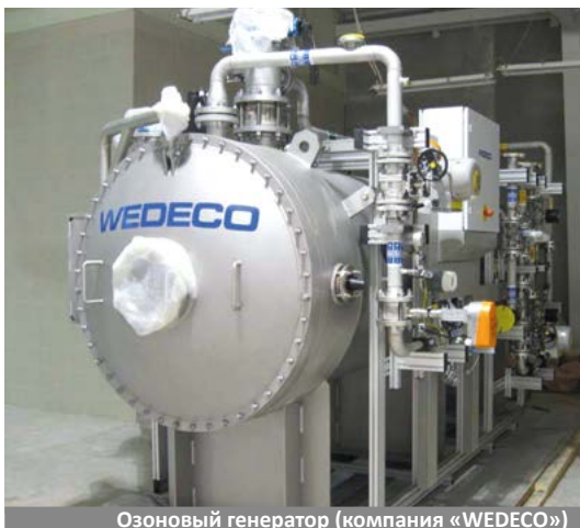
Озоновый генератор (компания «WEDECO»)
